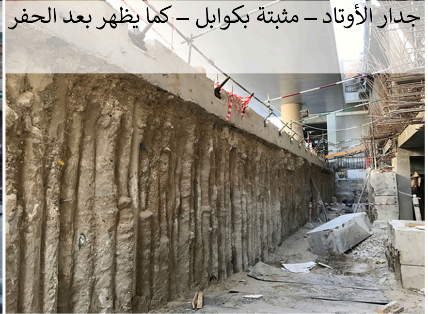
جدار الأوتاد - مثبتة بدعائم هيدروليكية - كما يظهر بعد الحفر
